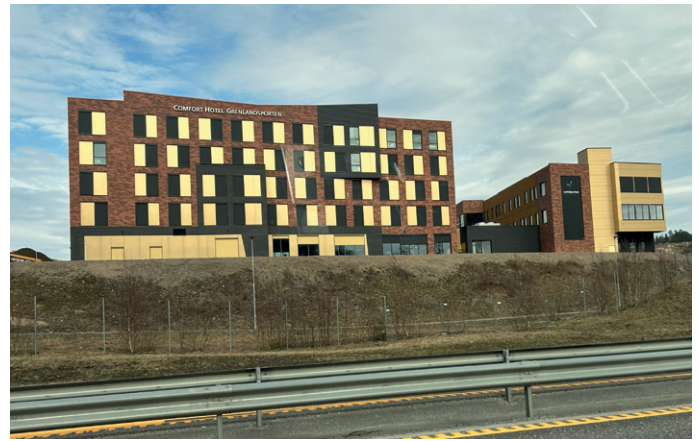
Prosjektet er godt synlig fra E18.
